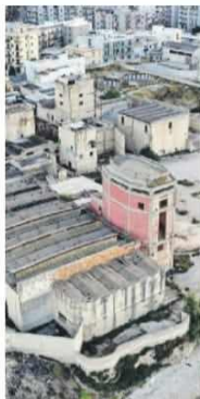
L'AREA L'ex distilleria
